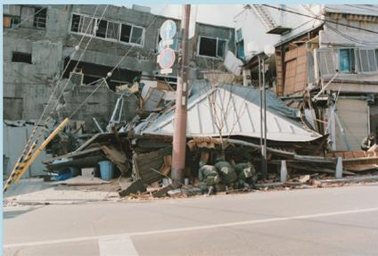
阪神淡路大震災で被害のあった家屋は、全壊が約10万5千棟、半壊が約14万4千棟に達しました。中央区を中心に、商業・業務施設等の非木造建築物でも、中間階が崩れた建物が多く見られました。(神戸市消防局 阪神淡路大震災 被害の状況(物的被害))
